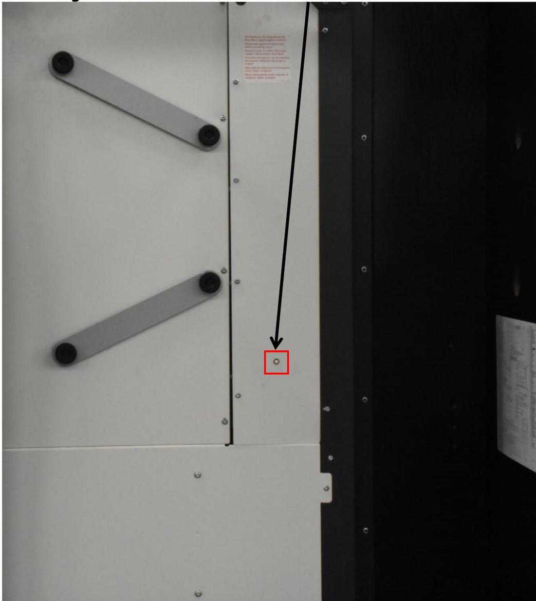
3. Tippen Sie für **drei Sekunden** auf den Reset Button. Die Wärmepumpe wird nun neu gestartet.
